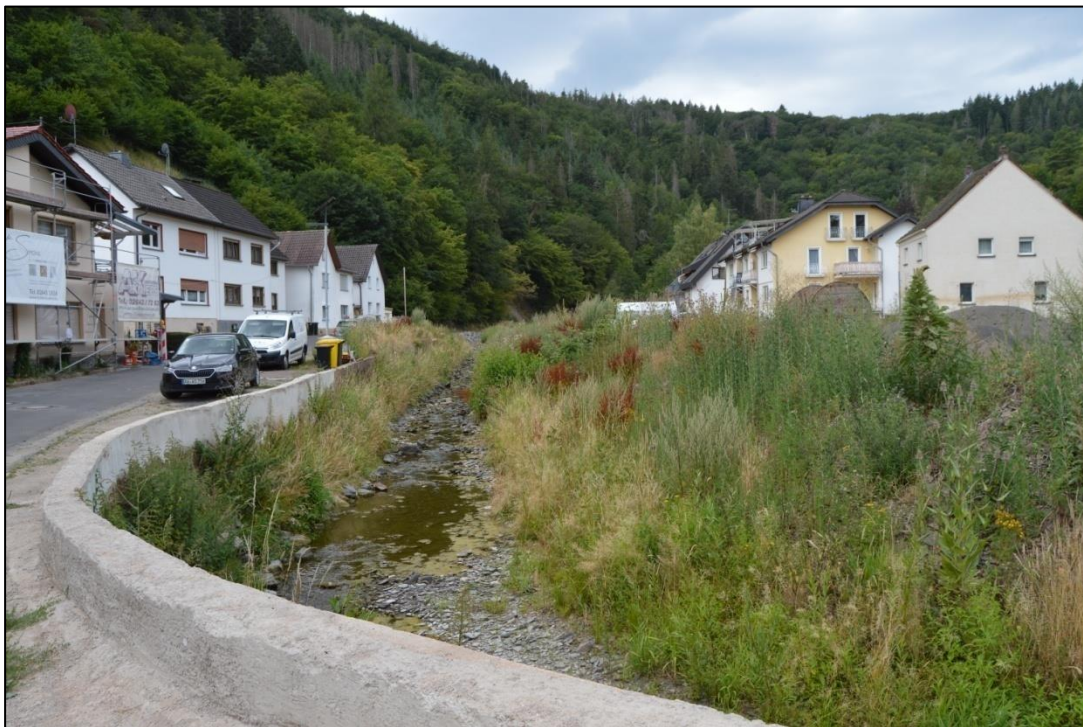
Abb. 11: Sahrbach und Stützwand bachaufwärts der Biegung; rechts im Bild die Siedlungsbrache, wo der Bach hin verlegt werden soll und zusätzlicher Retentionsraum geschaffen werden soll.
