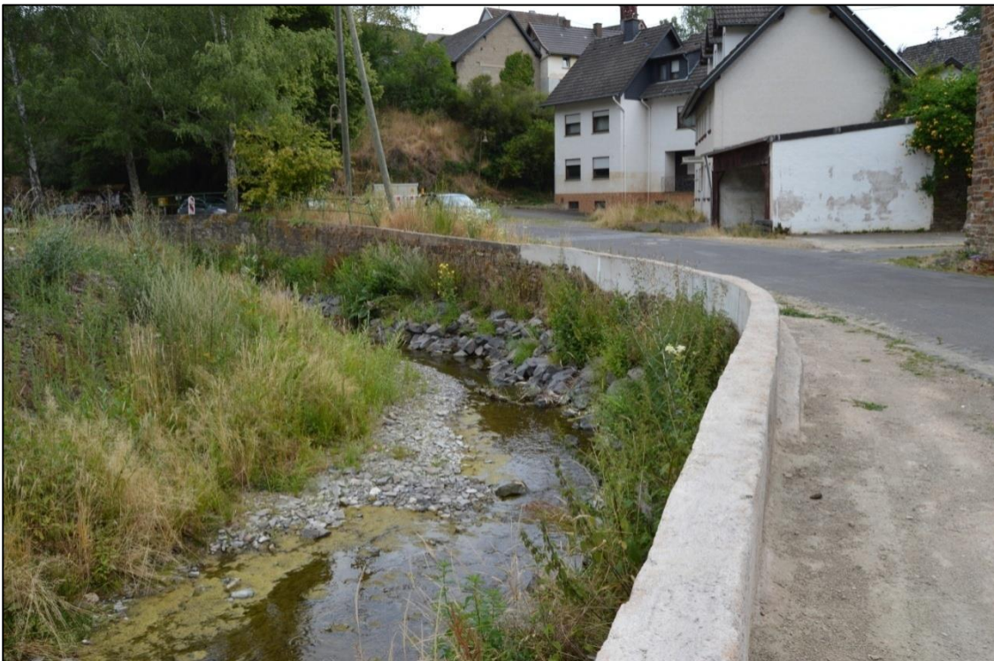
Abb. 10: Sahrbach mit Uferverbau - Gewässerbausteinen und Stützwand - im Bereich vor der Brücke; in der Biegung müssen Bach und Stützwand von der Straße weg verlegt werden.
