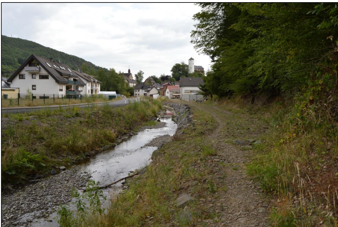
Abb. 12: Nach dem Hochwasser 2021 angeschütteter und mit Blocksteinen verbauter Bereich des Sahrbachufers oberhalb der Ortschaft.
